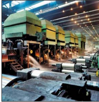
Figure 1: Hot rolling mill ThyssenKrupp Hoesch Hohenlimburg
